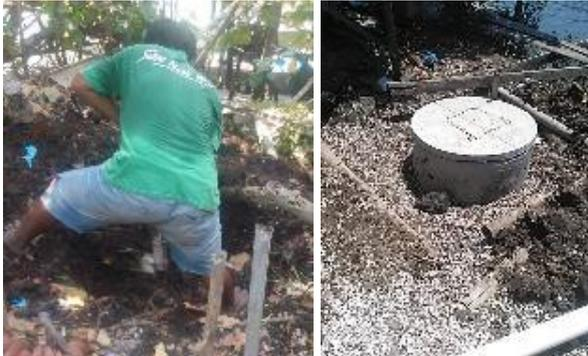
**Gambar 9** Pembangunan Jamban dan *septic tank* yang terbangun
