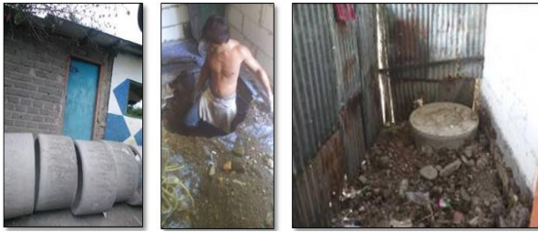
Gambar 9. Salah satu kondisi pembangunan cubluk di salah satu rumah warga RW 08
